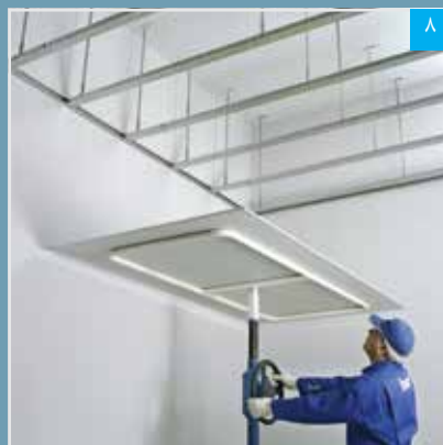
۸ استقرار پنل با استفاده از بالابر
