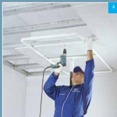
۸ اتصال پنل به زیرسازی توسط پیچ کناف
