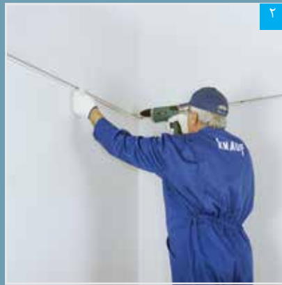
۲ نصب سازه تراز پس از تعیین خط تراز سقف
