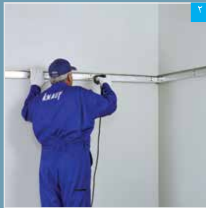
۲ نصب سازه تراز باربر
