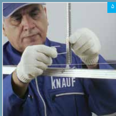
۵ اتصال چنگک به آویز و رگلاژ سقف توسط پین
