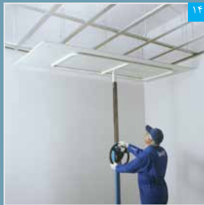
۱۴ استقرار پتل با استفاده از بالابر
