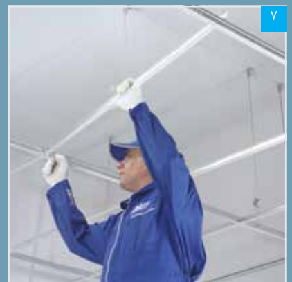
۷ اجرای سازه‌های فرعی T1200
