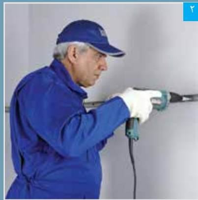
۲ نصب سازه تراز
