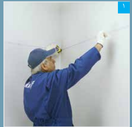
۱ مشخص کردن محل نصب سازه تراز باربر با ریسمان رنگی
