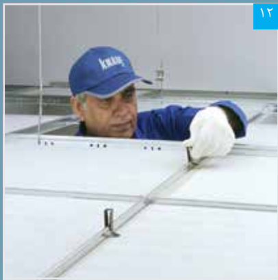
۱۲ قراردادن گیره‌های مخصوص نگهدارنده تایل
