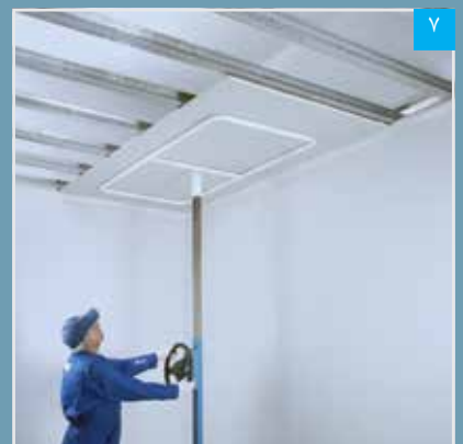
۷ استقرار پنل با استفاده از بالابر
