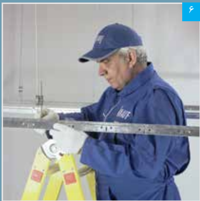
۶ اجرای سازه‌های اصلی T3600
