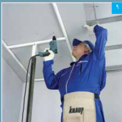
۹ اتصال پنل به زیرسازی توسط پیچ کناف
