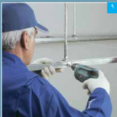
۹ اتصال سازه باربر به رکاب توسط پیچ LN
